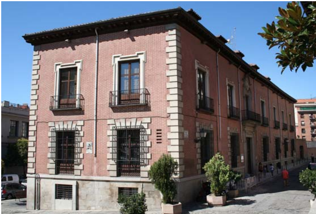
Vista actual del edificio
