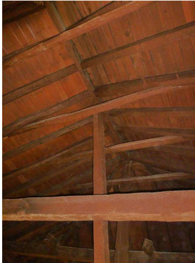
Vista actual de la estructura de soporte de la cubierta a base de vigas de madera
