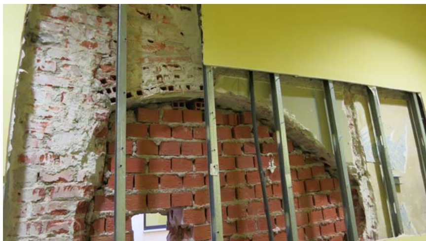
Vista de la cata abierta en la zona del arco del patio (planta baja)
