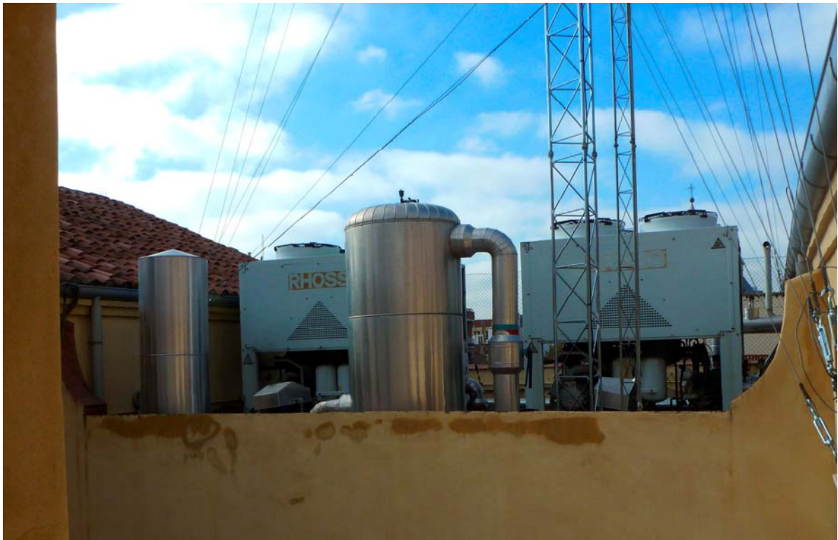
Modificación de forjados con refuerzo metálico para inserción de unidades de climatización
