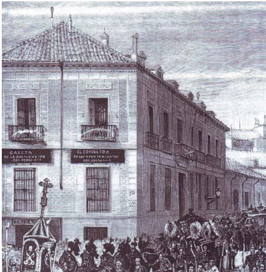
Detalle de un grabado de 22 de abril de 1888 en el que la fachada presenta ladrillo visto Fuente: El Consultor de los Ayuntamientos – La Ley
