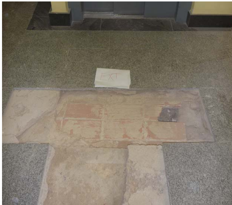
Forjado nueva ejecución con viguetas de hormigón y bovedilla conformada con 2 hojas de rasillón junto al ascensor
