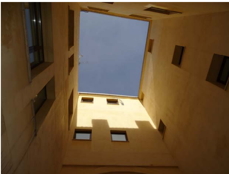
Vista actual del patio
