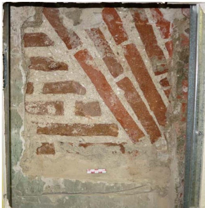
Vista de ladrillos de macizos bizcochados originales unidos con mortero de cal y arena
