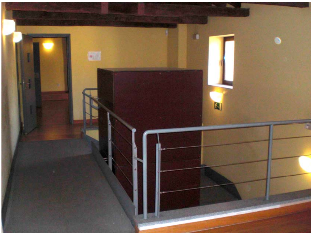
Aperturas de forjado para adaptación de escaleras
